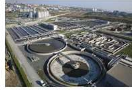
I- Su Arıtma Tesisi
